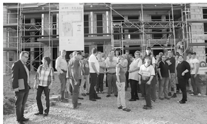
Erste Eindrücke vom Haus: Im September 2013 besuchen die Angehörigen der Bewohner des neuen St. Nikolaushauses den Rohbau.
